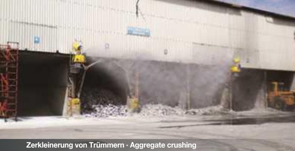
Zerkleinerung von Trümmern · Aggregate crushing
